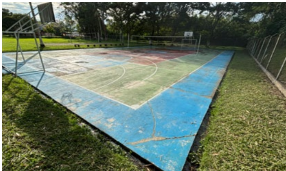
Imagen 147. Recubrimiento acrílico antideslizante
