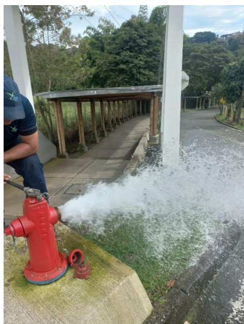
Imagen 134. Capacidad de respuesta hidrante
