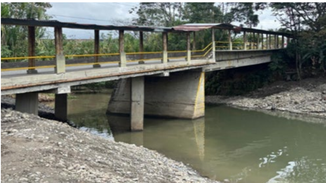
Imagen 136. Limpieza y retiro de material vegetal y residuos acumulados
