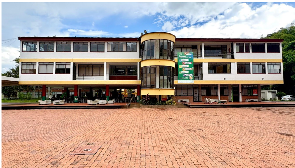
Imagen 150. Proyecto de reforzamiento estructural del edificio Aletheia
