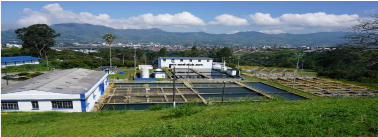
Figura 1: Planta de tratamiento Aguas ya Aguas de Pereira.
