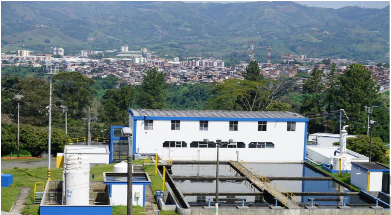
Figura 4: Planta de tratamiento Aguas y Aguas de Pereira. Fuente: Elaboración propia.
